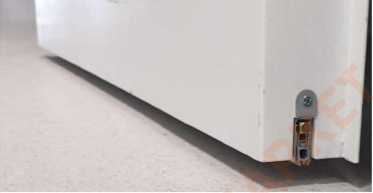
Şekil 2 Bina Hırdavatı Montaj Görünümü (Giyotin Fitol Sistemi)
